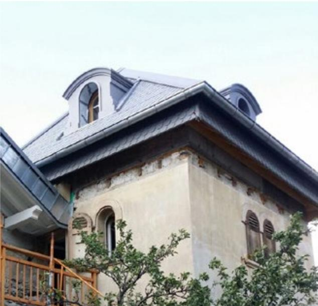
Die ganze Dachkonstruktion inklusiv Schindeleindeckung und Lukarnen wurde vor Ort erstellt und danach mit dem Kran direkt auf den Turm gesetzt und befestigt.
